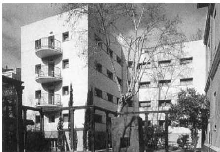
FOTO 5.1: Residencia de Señoritas. Edificio de Carlos Arniches. Madrid
